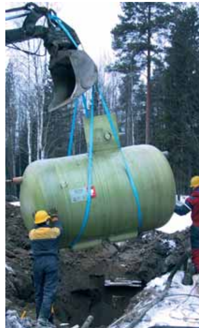
Labko BioKem 10 EN ja 15 EN -puhdistamoiden valmistusmateriaali on kestävä lujitemuovi.
